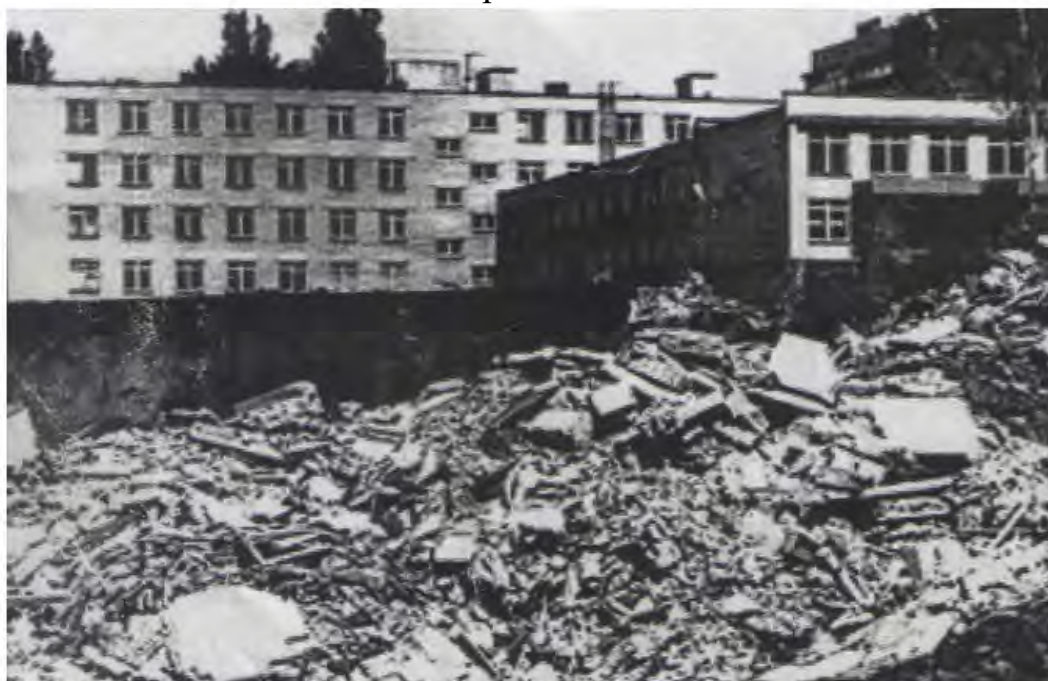
Рисунок 2 – Воронка оставшаяся после оползня
