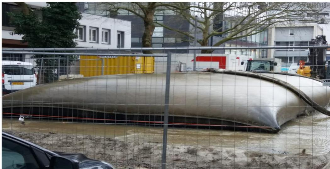
Рисунок 3 – Фильтрация пульпы
