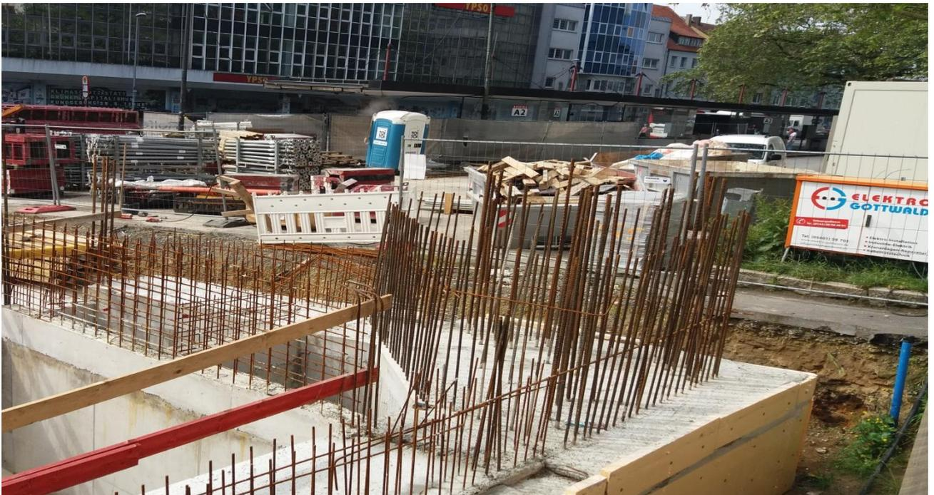
Рисунок 8 – Армирование стен будущего здания
