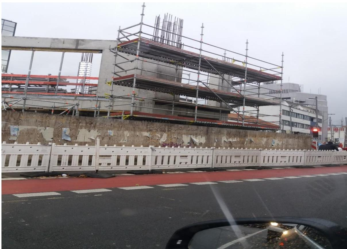
Рисунок 9 – Возведение монолитных стен
